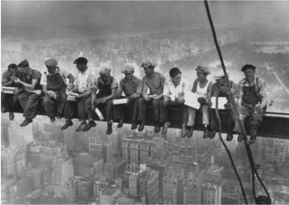
PERICOLI SUL LAVORO
